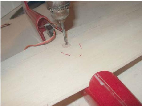
Flügel auf dem Rumpf ausrichten und das Befestigungsloch (4mm) im Abstand von 90mm zur Flügel Nase bohren. Es wird gleichzeitig durch das Haltebrett im Rumpf gebohrt
