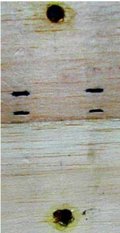
Die Bohrlöcher im Flügel weitet man unten etwas auf, und füllt die Löcher mit Harz. Anschließend werden die Löcher nochmal gebohrt. Auf diese Art erhält man eine stabile Schraubenführung.
